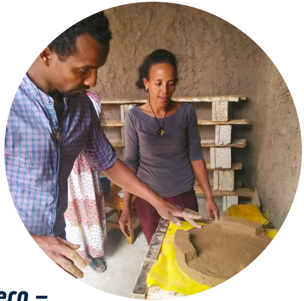
Bau eines Lehmofens, der fast rauchfreies Kochen ermöglicht
